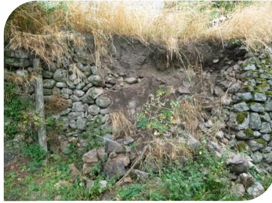
*Etat initial : un mur écroulé sur 3 m de large et 2,5 m de haut : un gros travail en perspective !*
