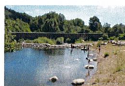
La pose de blocs de rocher autour de la plage.
