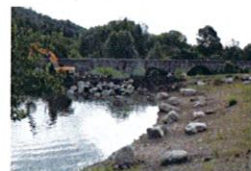
La construction de la digue.
